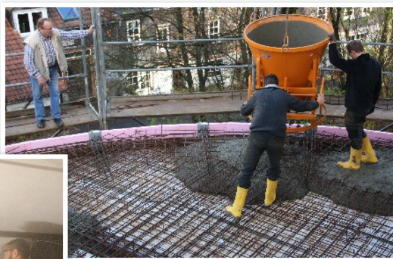
Gießen der Bodenplatte.
