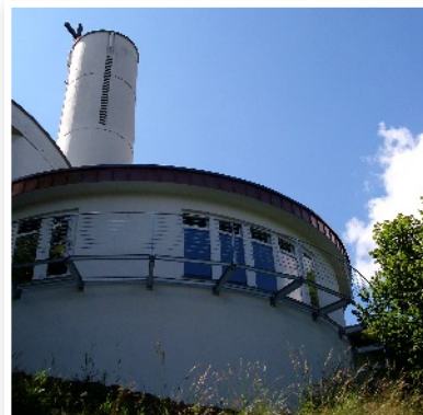
Der Anbau - auch von aussen sehr gut gelungen.
