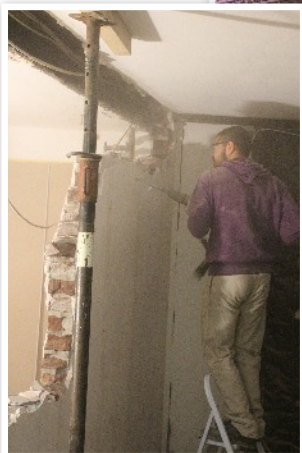
Schweißtreibende und staubige Arbeiten waren nötig.
