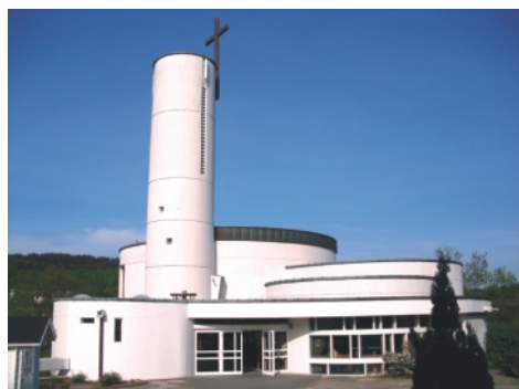
Auferstehungskirche Trupbach Am Wurmberg 5, 57072 Siegen-Trupbach
